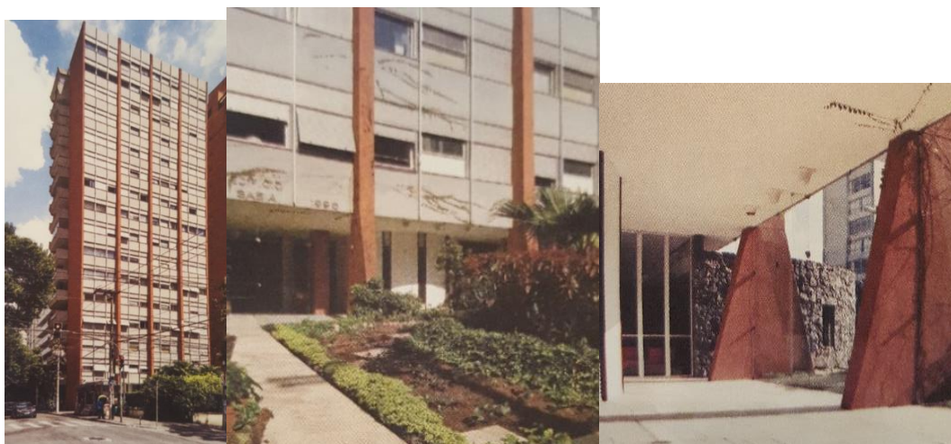
Figuras 17, 18 e 19 – Fachada, entrada e vista dos pilares, respectivamente, do Edifício Sabiá.
