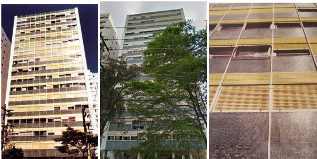
Figuras 12, 13 e 14 – Edifício Garça Real na década de 60 e nos dias de hoje, respectivamente. Fonte: (SERAPIÃO, 2006).
