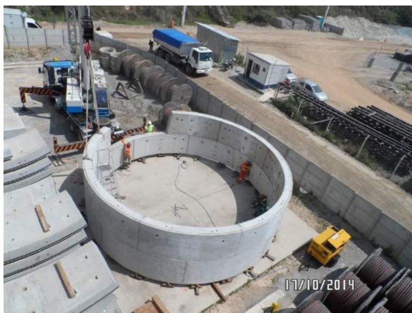
Figura 03. Montagem de anéis pré-montados do túnel singelo
