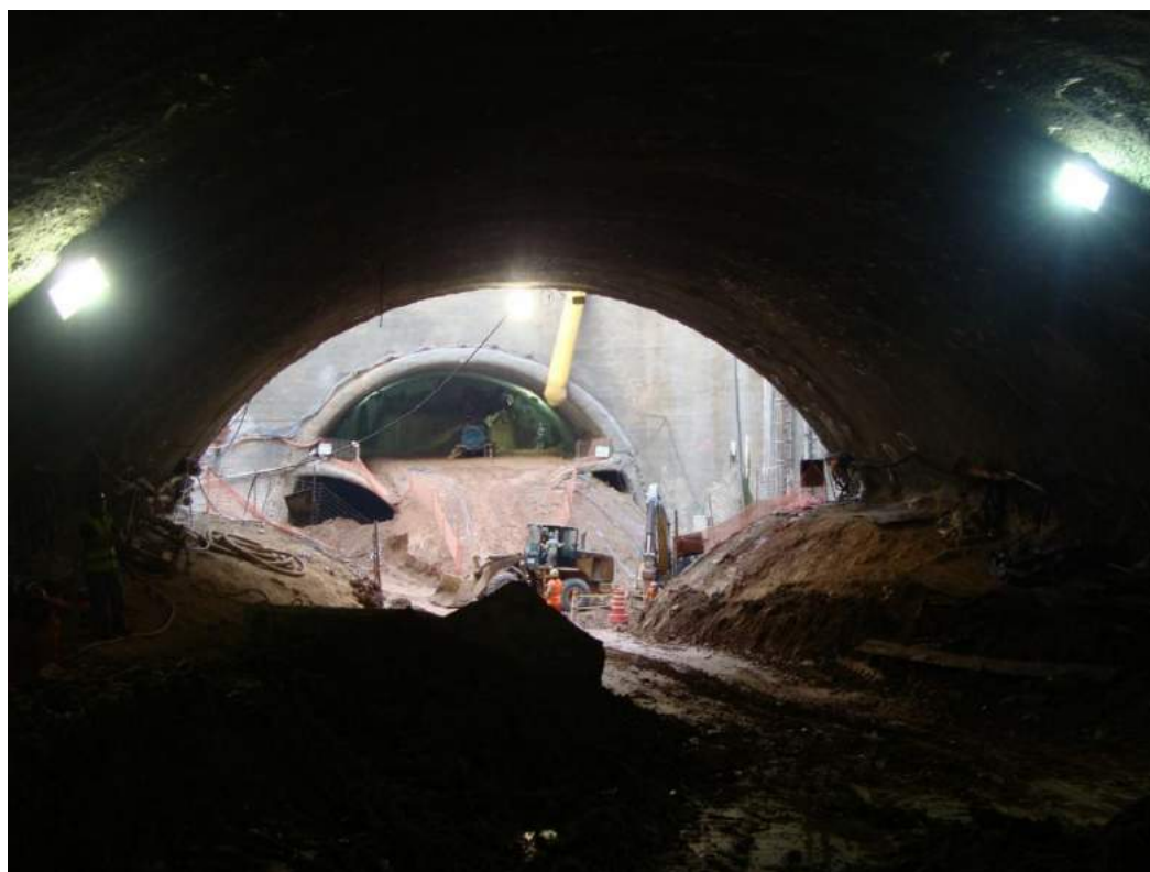
Figura 01. Escavação do túnel duplo em NATM
