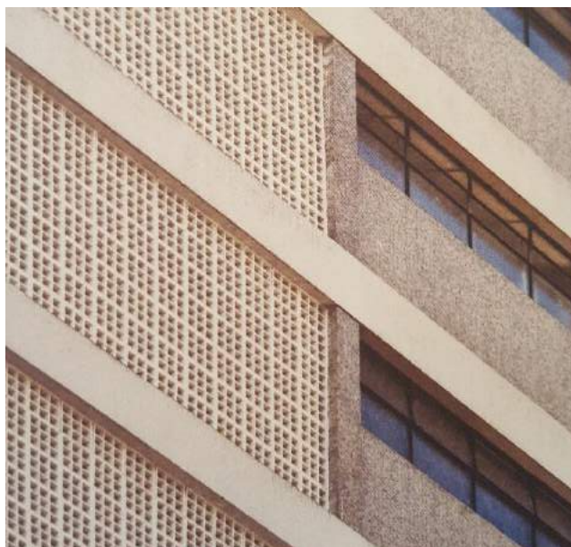
Figura 1 – Elemento vazado na fachada do Edifício Lorena. Fonte: GUERRA, SERAPIÃO E GIMENEZ, (2016, p. 220).
