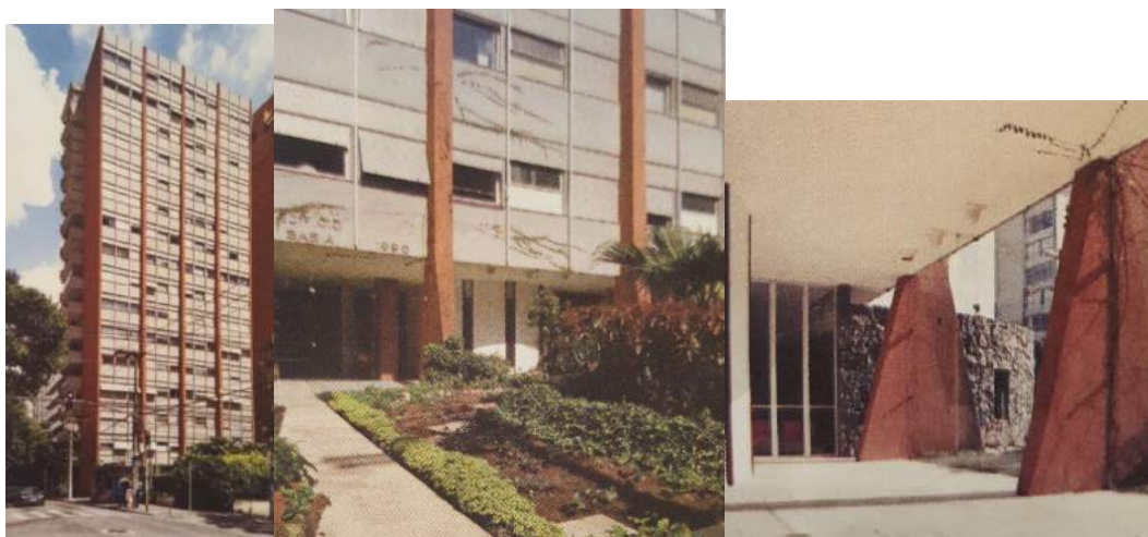
Figuras 17, 18 e 19 – Fachada, entrada e vista dos pilares, respectivamente, do Edifício Sabiá.
